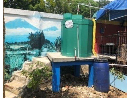
Biodigester (mengubah sampah organik menjadi gas untuk memasak)
